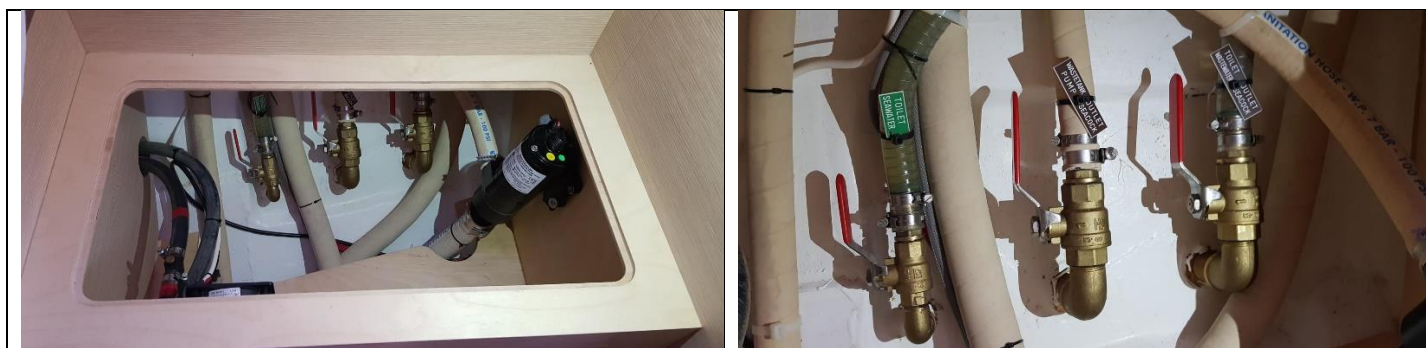
Zdjęcie 22. Umieszczenie odpływów i dopływu do WC przy kabinie dziobowej prawej. Na zdjęciu wszystkie zawory są otwarte.
